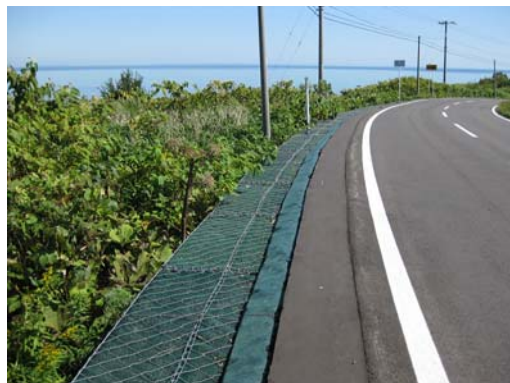
写真 5 崩落防止工事の跡が確認できる(地点 S-3)。
